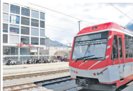
Mehrbedarf. In der Hochsaison werden an das Bahnstromnetz der MGB hohe Ansprüche gestellt. FOTO WB
